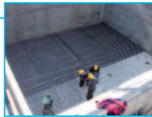
Installation des busettes dans le filtre
